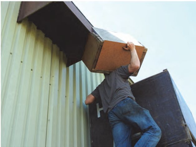
De nieuwe woning wordt op de kuubkisten geplaatst
